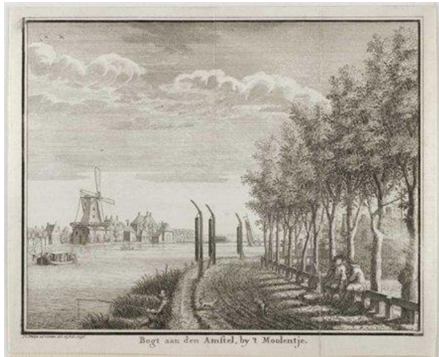
Rolpalen, zoals hier, stonden in bochten van een rivier waarover veel trekschuiten passeerden. Die palen voorkwamen dat de treklijn van het schip over de weg werd getrokken.
